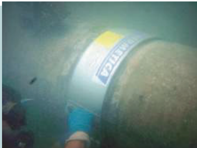
Fig. 2 / Montaje submarino. Abrazadera HERMETICA SF fabricada en acero inoxidable AISI 316.
