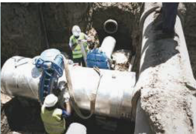
Fig. 6 / Montaje de tuberías y accesorios.
